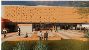
Vista do acervo de livros. Fachada ventilada com peças perfuradas e blocos cheios.
